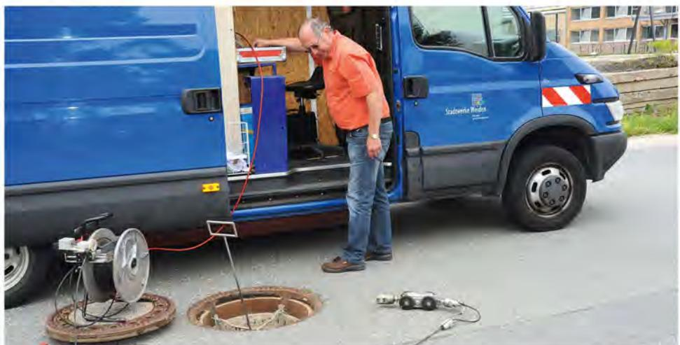
Kanalmeister Roland Gallei bereitet den Einsatz der Kanalkamera ins Rohrsystem vor. Im Fahrzeug befinden sich Computer und Bildschirm. Hier laufen die Bilder der Kamera auf, mögliche Schäden werden sichtbar. Auch Videoaufzeichnungen zur Dokumentation und nachträglichen Auswertungen von Schäden sind möglich.
