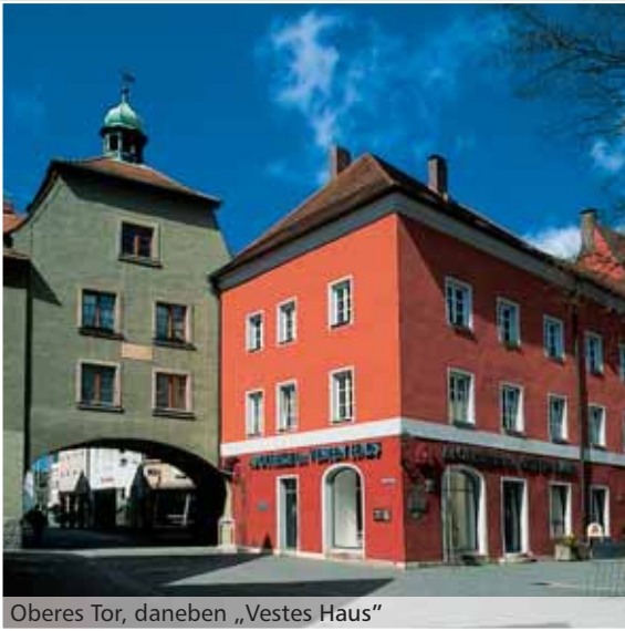
Oberes Tor, daneben „Vestes Haus“
